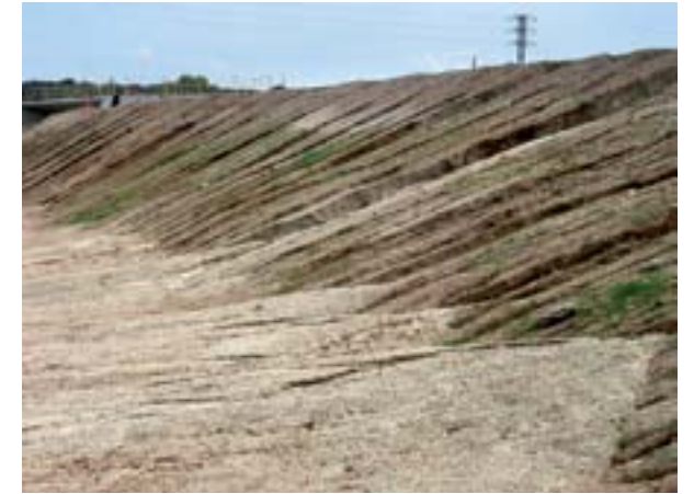
Figura 15. Erosión hídrica muy severa en terraplenes de una autovía. La paralización de las obras impidió el extendido de tierra vegetal y la revegetación durante un largo periodo de tiempo (Foto: J.F. Martín Duque).
