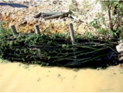
Figura 8. Empalizadas trenzadas vivas en la orilla de un río (taller AEIP, Orense, 2008; taller Ripidurable, Alpiarça, 2007; adaptado de Florineth 2004).
