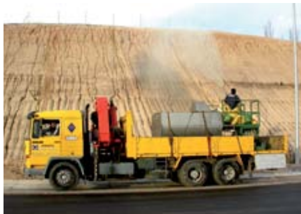
Figura 10. La hidrosiembra es una técnica habitual para sembrar semillas en amplias superficies, como los taludes que se generan al crear vías de transporte. La hidrosembadora consiste en un vehículo equipado con un tanque o cisterna en cuyo interior se mantiene en el cóctel en permanente agitación para asegurar una mezcla homogénea. Los modelos de mayores dimensiones, como el que aparece en la imagen, cuentan con una torreta en la parte superior desde la cual proyectar con una manguera la siembra (Foto: María Altamirano; OHL).
