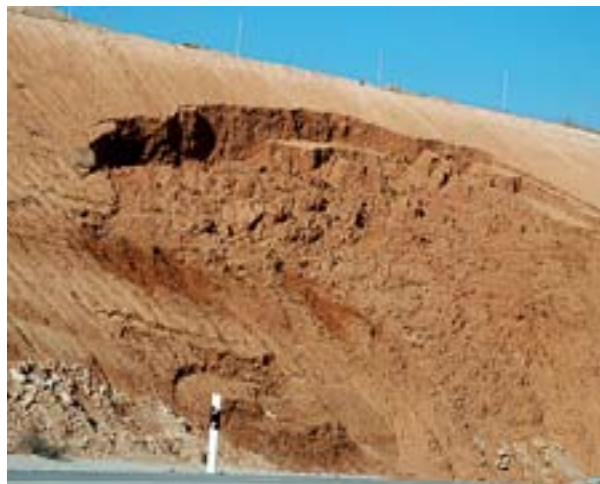
Figura 5. Ejemplo de seepage erosion en un desmonte construido sobre materiales arenosos (Foto: J. Vázquez).
