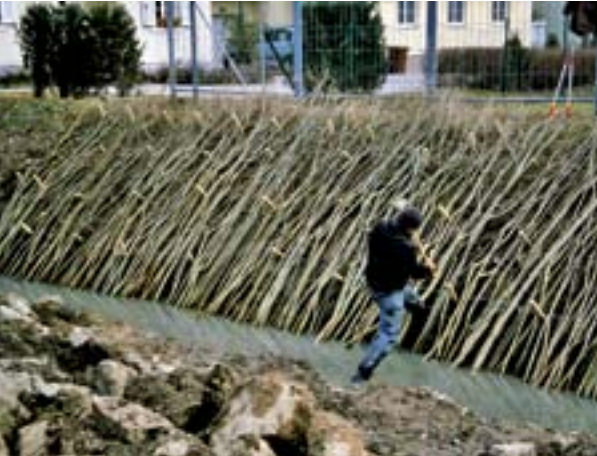
Figura 10. Fijación con alambres tensos (taller práctico, Viena, Austria).
