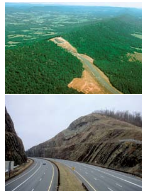
Figura 13. Superior: fotografía aérea oblicua del Sideling Hill Road Cut . El corte realizado por la autopista permite reconocer la estructura interior de un sinclinal colgado, el cual forma la alineación montañosa de la imagen. (Foto: Maryland Geological Survey, 1998). Inferior: detalle del corte y de la estructura geológica desde una plataforma habilitada para su observación (Foto: J.F. Martín Duque).
