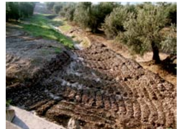
Figura 5. Gavionado flexible como refuerzo de la salida de un paso inferior. Jabalquinto, Jaén.
