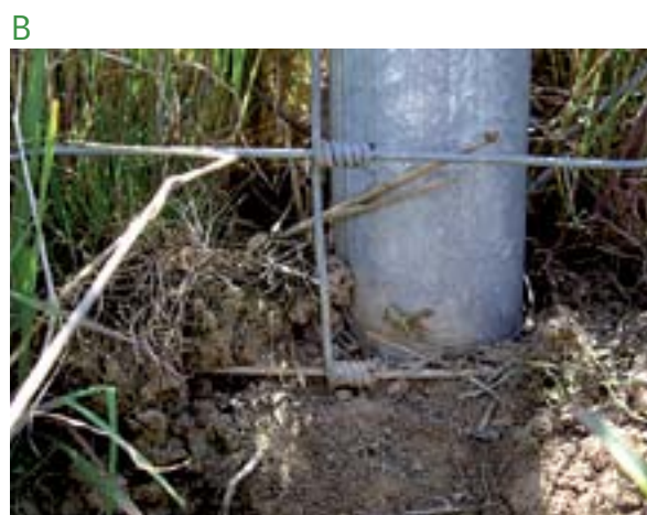
Figura 3. Ejemplos de buenas prácticas en cerramientos: vallado especial para evitar el acceso de anfibios a la calzada (A), ubicado en un tramo conflictivo por el paso estacional de anfibios en la carretera M-618 (Madrid), y detalle de vallado enterrado en la base (B) en la autopista AP-51 en la provincia de Ávila.
