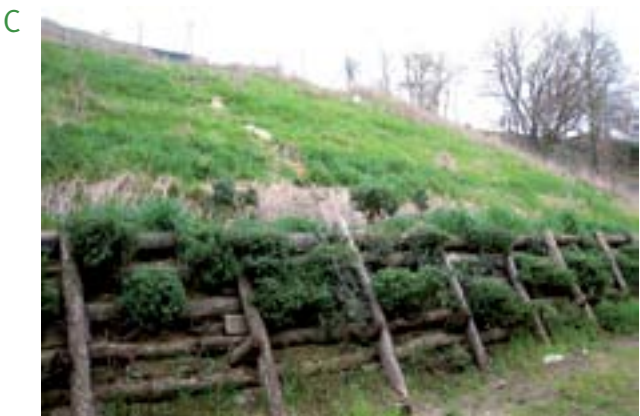
Figura 13. Entramado sencillo de una pared (A, tomado de Florineth 2004), entramado tipo 'Roma' (Paolo Cornellini, B), y entramado tipo 'Latina' (Paolo Cornellini y Sauli; 2005, C y D).
