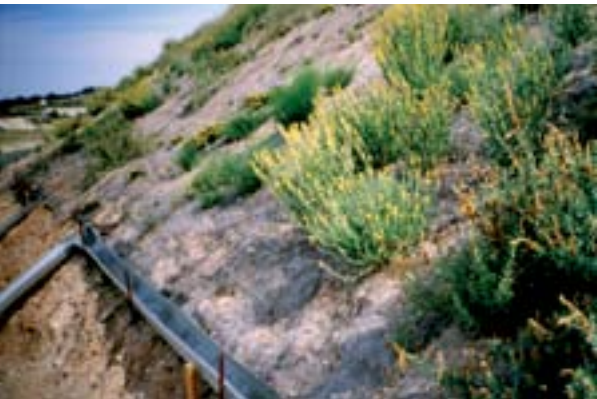
Figura 15. Vista del talud del ejemplo.
