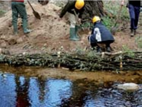
Figura 8. Empalizadas trenzadas vivas en la orilla de un río (taller AEIP, Orense, 2008; taller Ripidurable, Alpiarça, 2007; adaptado de Florineth 2004).
