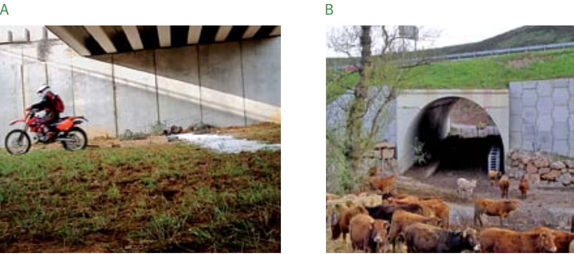
Figura 10. Usos inadecuados que comprometen la efectividad de los pasos inferiores específicos: tránsito de vehículos (A) y aprovechamiento del paso como establo (B).
