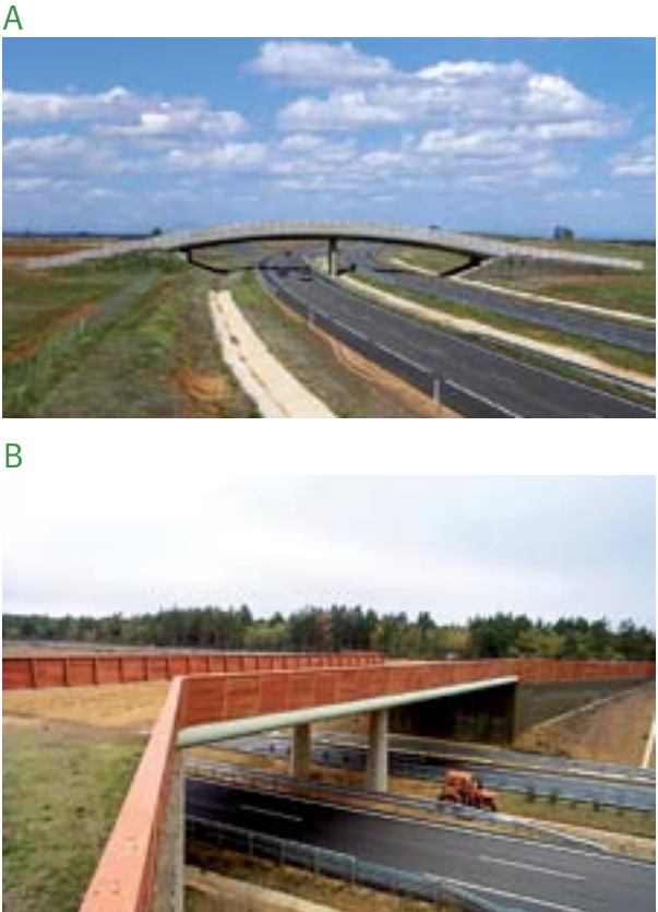
Figura 11. Pasos superiores específicos: paso en forma de diábolo construido en un tramo en la provincia de Palencia en la autovía A-231 (A) y otro paso ubicado en el tramo leonés de la autovía A-66, en el que se pueden observar como los accesos son tendidos para favorecer su uso por la fauna (B).
