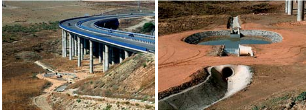
Figura 16. Izquierda: ejemplo de una balsa de decantación de sedimentos y de contención de vertidos accidentales, conectada al sistema de drenaje de la autopista Radial 4 (Madrid). En la imagen pueden observarse, además de la infraestructura lineal, la bajante desde el terraplén, la cuneta que conduce la escorrentía y los sedimentos a la balsa; el canal de entrada; la balsa; y el vertedero de la balsa a la red fluvial del entorno (arroyo Salinas). Derecha: detalle de la misma balsa, en el que se aprecian mejor alguno de los elementos que la componen: el canal de entrada, la reja de desbaste, la balsa, el canal de vertido y el arroyo Salinas (al fondo) (Fotos: Javier Martínez de Castilla Colomer, Ferroviario-Agromán SA).
