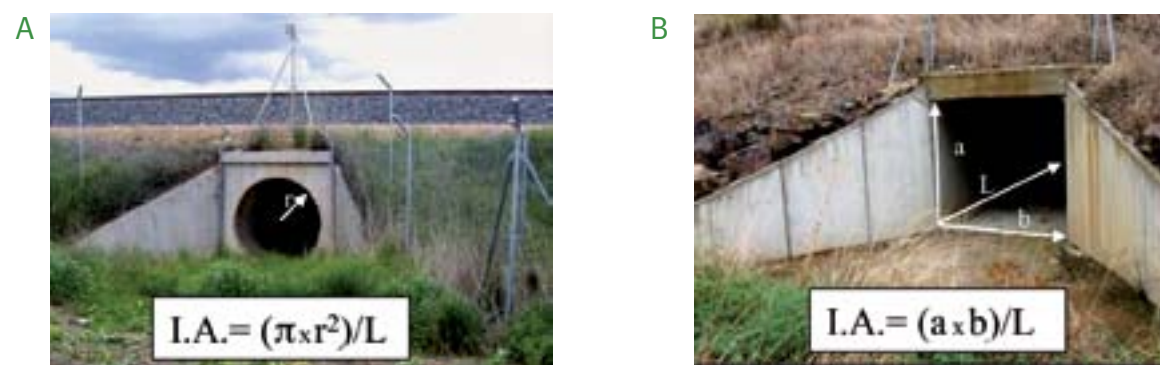
Figura 6. Ejemplos de cálculo del índice de apertura en dos drenajes de diferente sección: drenaje circular (izquierda) y drenaje adecuado (derecha).
