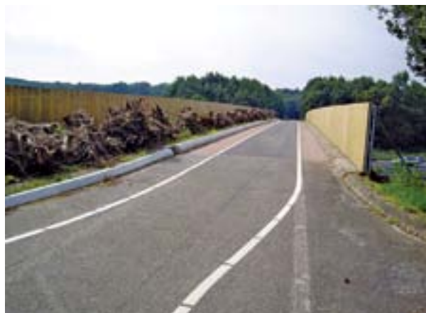
Figura 8. Dos tipos de adaptaciones para favorecer el tránsito de la fauna por los pasos superiores multifuncionales: la colocación de tocones de madera (A) y la revegetación de los laterales (B). Ambos ejemplos proceden de autovías holandesas.
