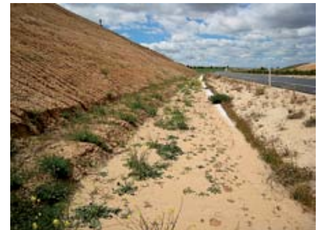
Figura 8. Acumulación de sedimentos procedentes de un desmonte, que prácticamente colmata una cuneta (Foto: J.F. Martín Duque).
